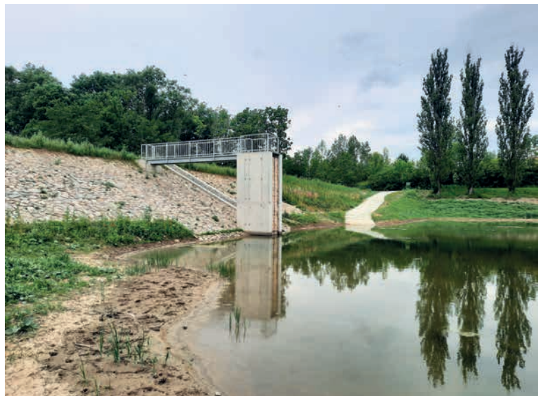
Opraveno bylo také samotné výpustné zařízení včetně spodních výpustí ↑
